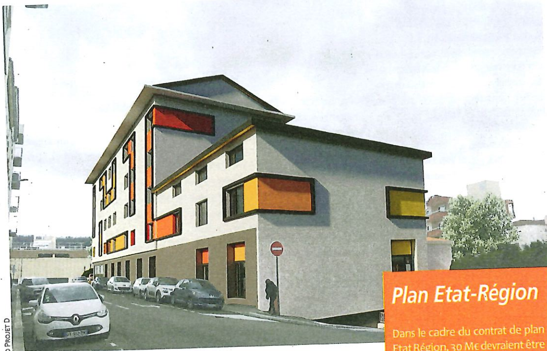
Le bâtiment de 3 200 m 2 sera entièrement réhabilité
